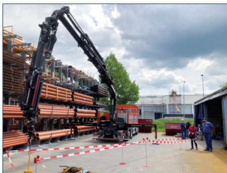
Unterweisung an einem LKW-Ladekran
